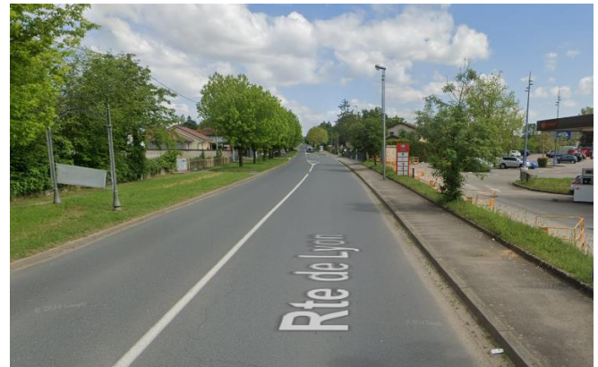
Arrêt provisoire au niveau du Carrefour Market
